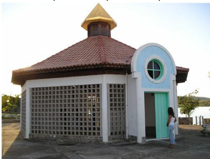
Figura 6: Foto da lavanderia pública em Salto da Divisa. Fonte: IBAMA (2005a).
