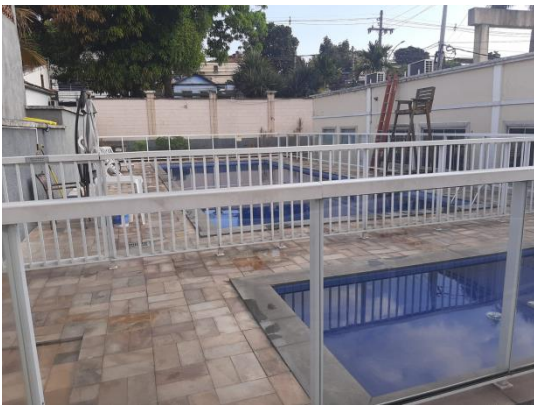
Figura 31 - Piscinas do Condomínio Riviera Maia
