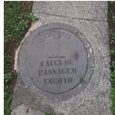
Figura 15 - Caixa de passagem de esgoto do Condomínio Riviera Maia
