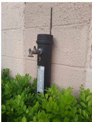
Figura 16 - Bica de água da chuva do Condomínio Riviera Maia
