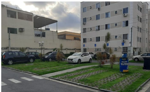
Figura 25 - Estacionamento do Condomínio Riviera Maia
