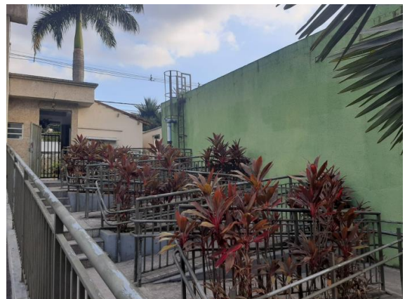
Figura 19 - Rampa de acesso ao Condomínio Riviera Maia
