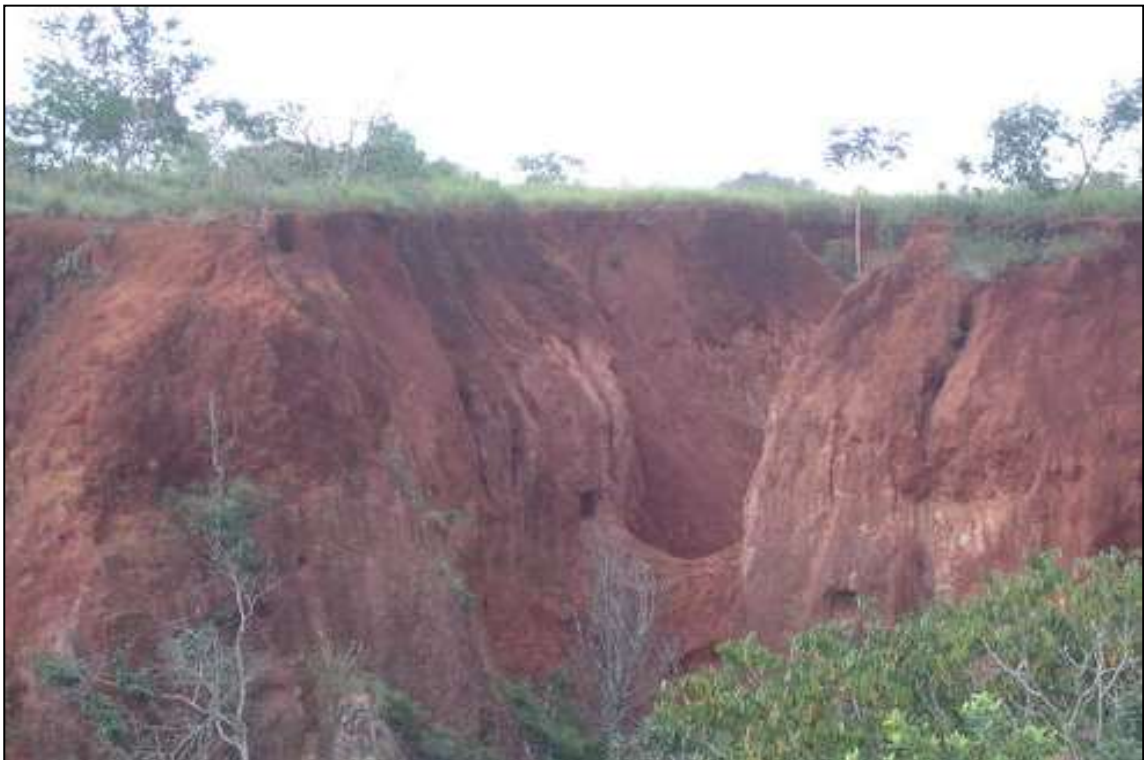
Figura 05 – Voçoroca na Fazenda Mijolinho no município de Palmelo. Foto: CARNEIRO, V. A. Abr./2010.
