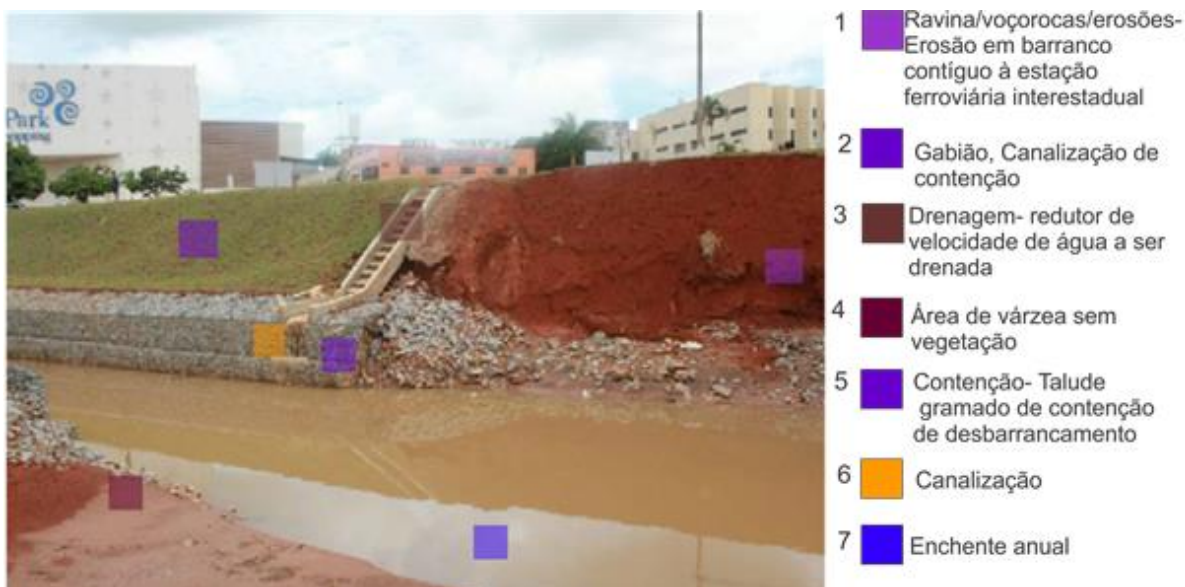
Foto 39 Rio das Antas sendo canalizado no Andracel, após o Shopping Fotos aéreas: (Potenciano, 2013)Legenda Autora com base no WEBQDA
