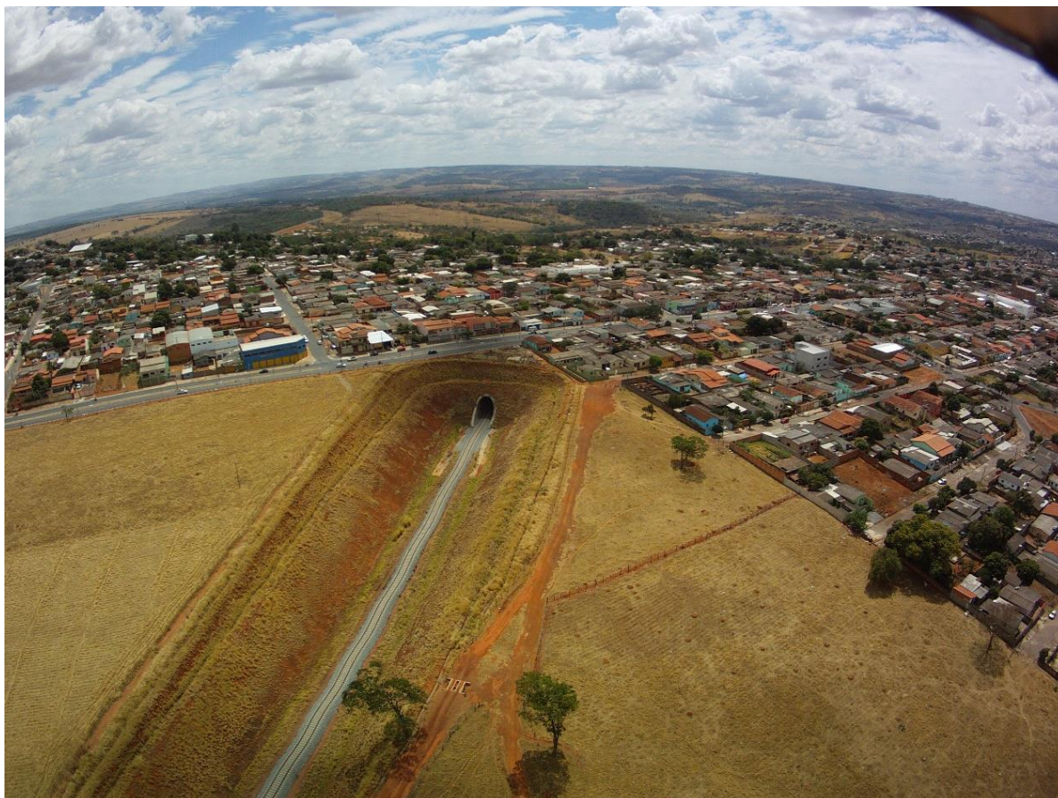
Foto 16 Túnel, Avenida Pedro Ludovico, Bairro Parque das Primaveras, Bairro Paraíso Foto aérea: (Potenciano, 2013)
