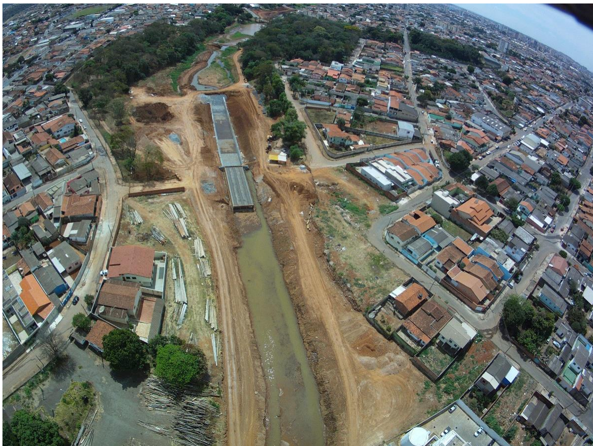
Foto 32 Bacias de contenção do Central Park Onofre Quinan. Obras da canalização e o Parque CPOQ
