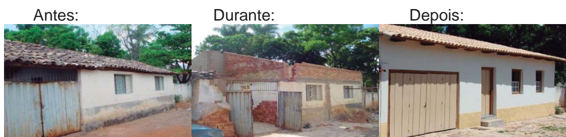
Figura 13: Fotos de imóveis privados em Goiás: antes, durante e depois da reforma.
