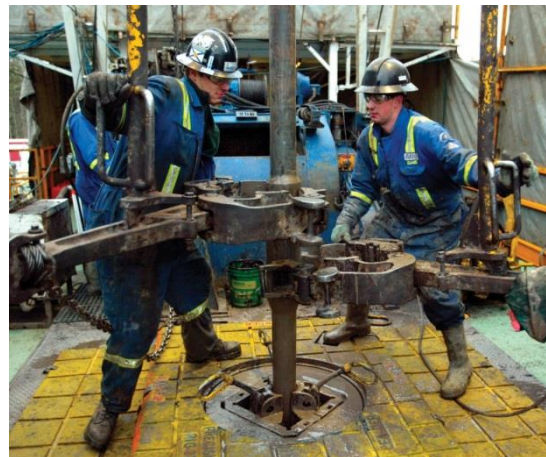
Posicionamento da broca perfuração
