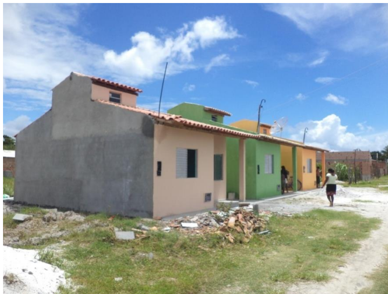
Figura 19 - Casas em fase final de construção em Belmonte/BA – Projeto construção de habitações populares para pescadores
