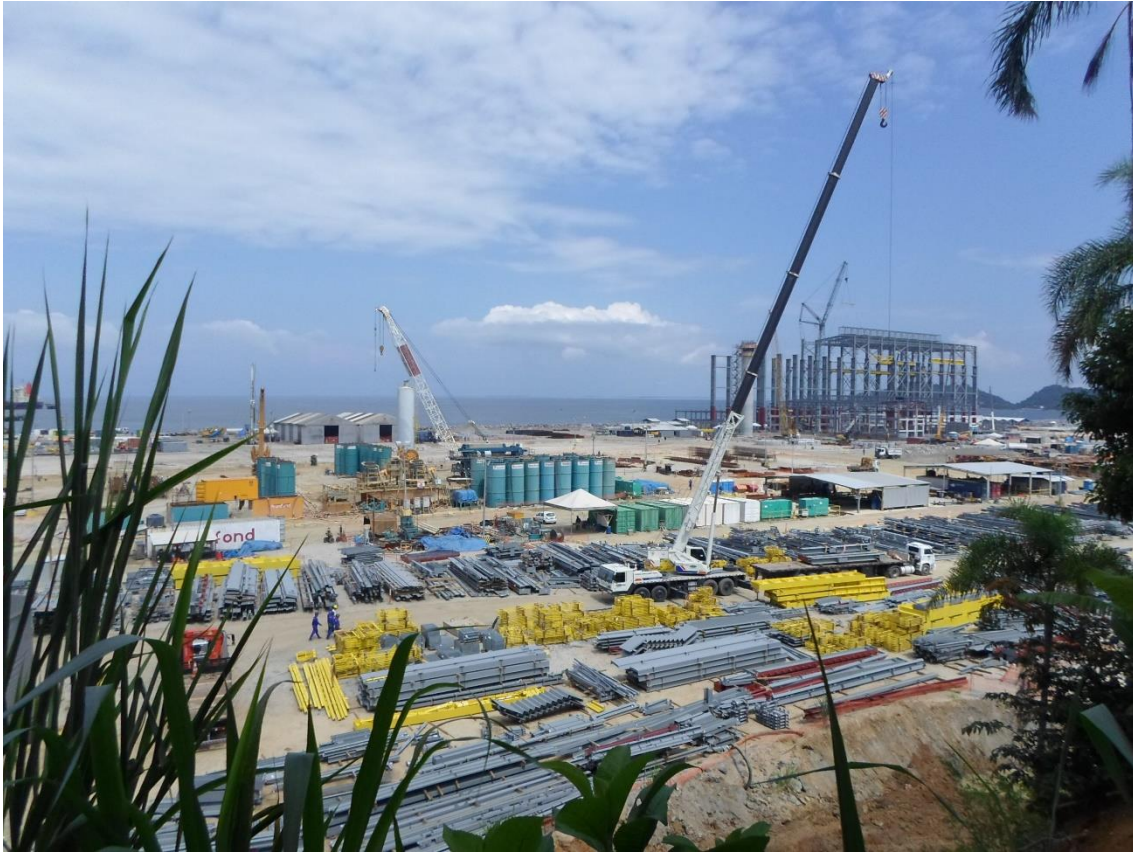
Figura 4 - Área em construção do Estaleiro e Base Naval da Marinha do Brasil.
