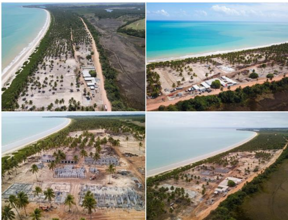
Figura 73 – Andamento das obras de construção do resort Vila Galé Alagoas na praia de Carro Quebrado na Barra de Santo Antônio, município inserido nos limites da APA Costa dos Corais. Fonte: Instagram da Sedetur/AL (2020;2021).
