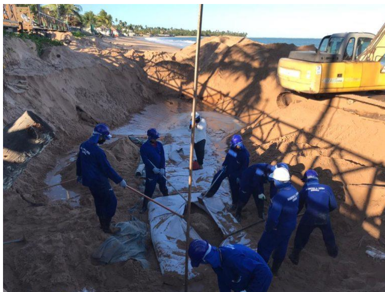
Figura 70 – Obra tipo Sandbag para conter erosão costeira no litoral norte de Alagoas. Fonte: IMA (2020).
