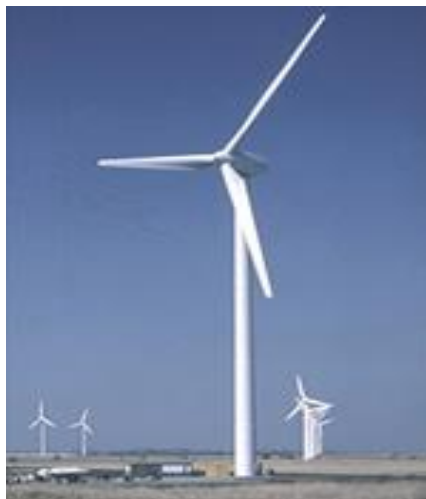
Figura 5 - Aerogerador de eixo horizontal
