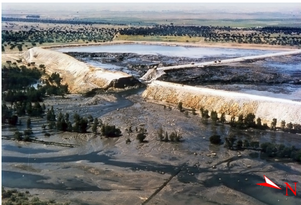
Figura 4: Deslizamento da mina de Aznalcóllar
