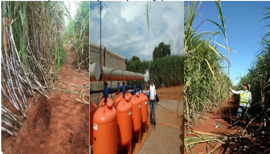
Figura 20 – Sistema de Gotejamento Subsuperficial para irrigação da Cana-de-açúcar e cana desenvolvida.
