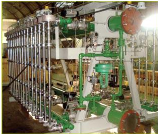
Imagem 1- Liners de hidrociclones no skid . Fonte: Fap do Brasil (2013).
